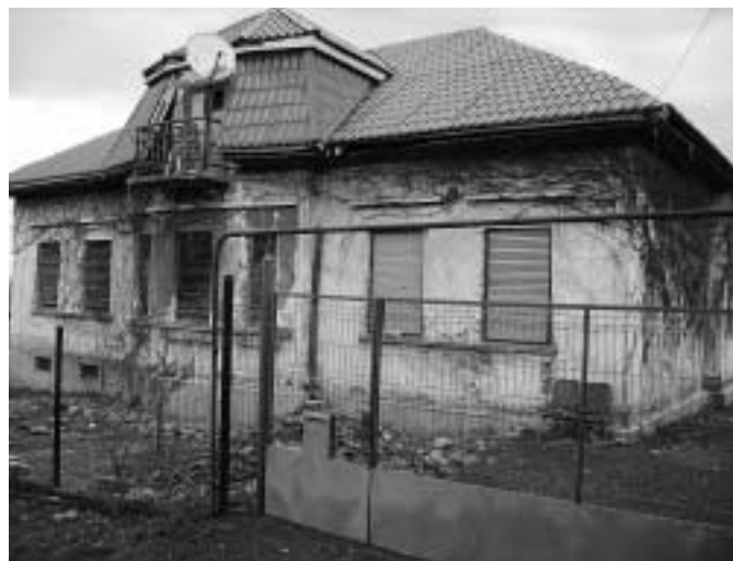
Aufnahme aus dem Jahr 2011 des Gebäudes auf dem Driglowetz in Reschitz, in dem sich früher die Gaststätte der Familie Gutjahr befand. Es hatte in den 1930er und -40er Jahren Restauration hinter dem Haus, eine Terrasse mit Tanzfläche und eine Kegelbahn. Foto: Robert L. Fabry
